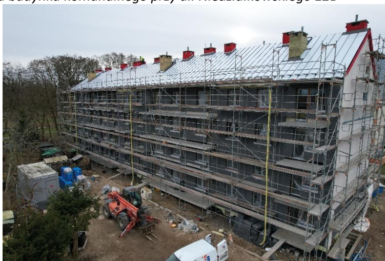
Rysunek 4. Budowa budynku komunalnego przy ul. Niedziałkowskiego 12D
