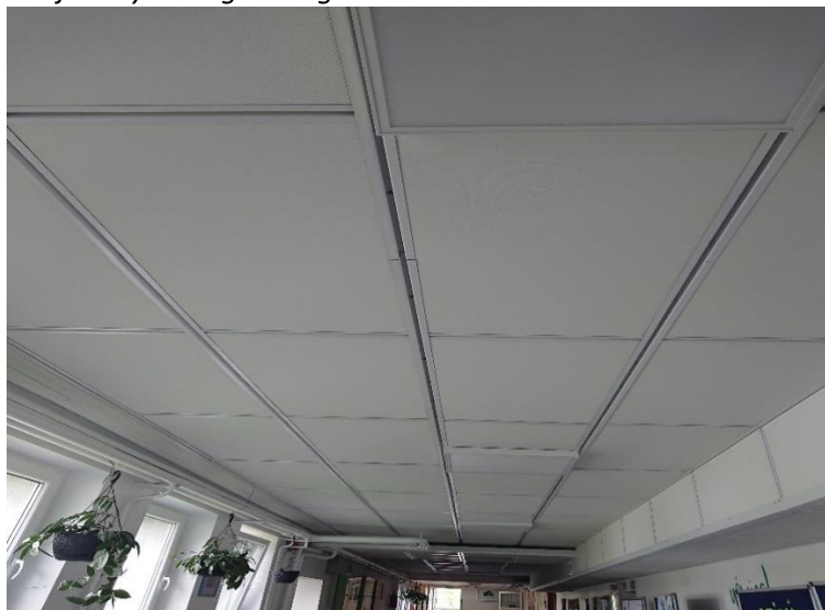
Rysunek 6. Modernizacja korytarza głównego w SP 3 w Policach
