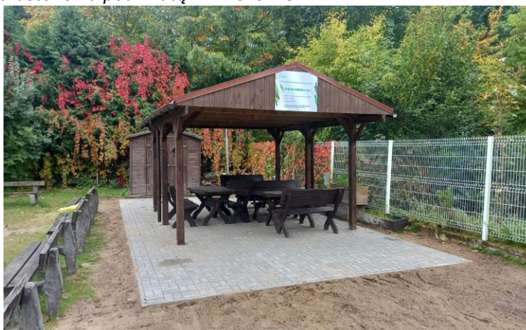
Rysunek 10 . Kostka betonowa pod wiatą w Pilichowie
