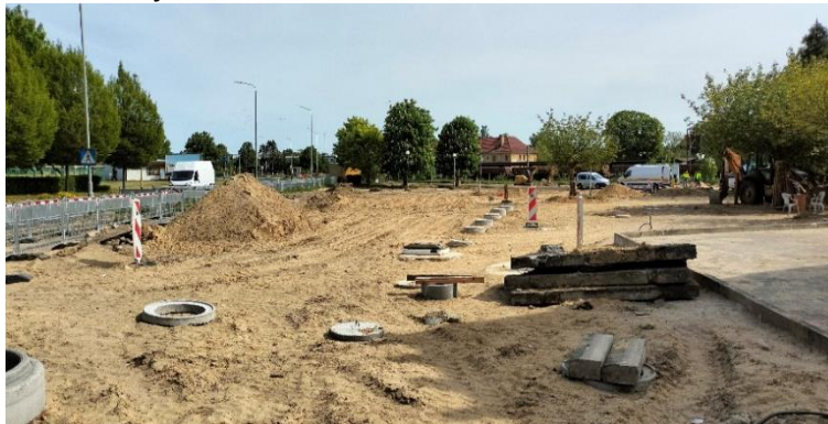
Rysunek 7. Budowa - SKM Stacja Police
