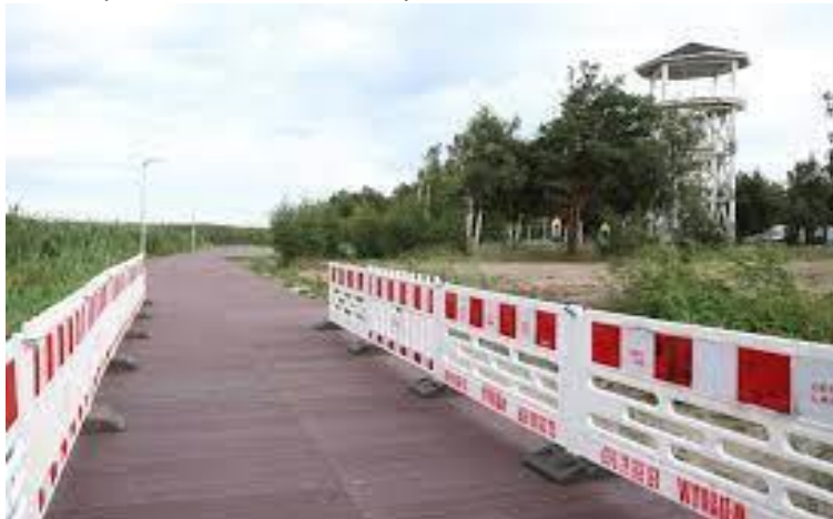
Rysunek 22. Odbudowana promenada w Trzebieży
