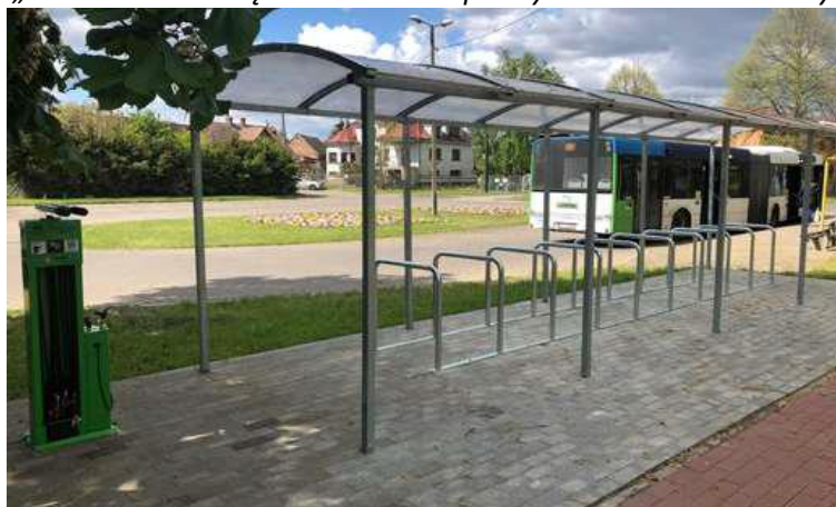
Rysunek 23. Obiekt „Bike&Ride” z urządzeniami do naprawy rowerów w Trzebieży
