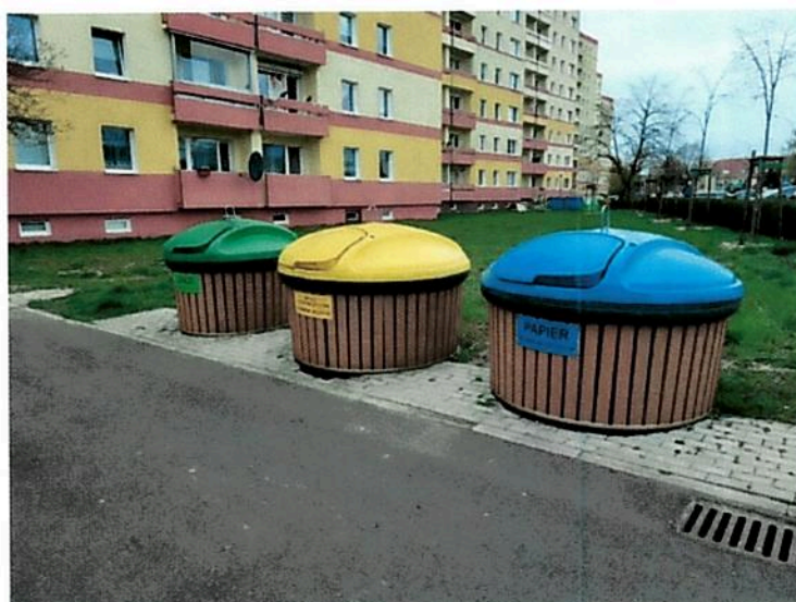
Fot. nr 1 Komplet pojemników półpodziemnych do segregacji
