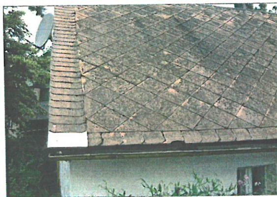
Fot. 2 Płyty azbestowo-cementowe płaskie
