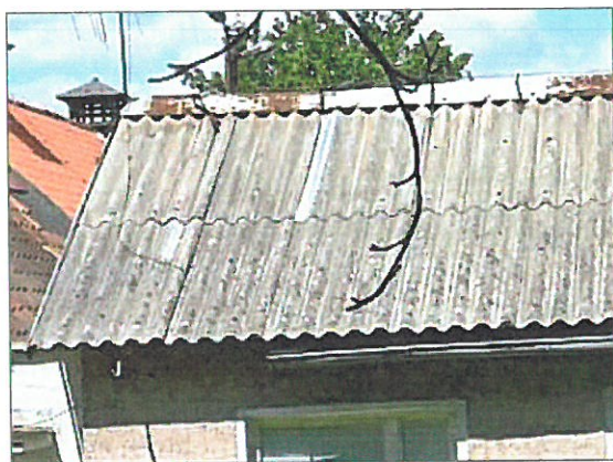
Fot.1 Płyty azbestowo-cementowe faliste
