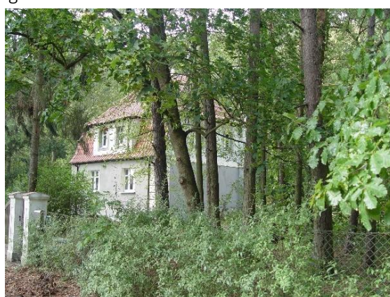
Widok od strony południowej.
