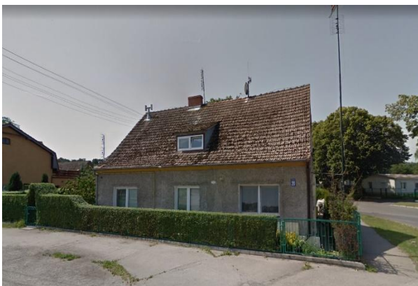
Widok od strony wschodniej
