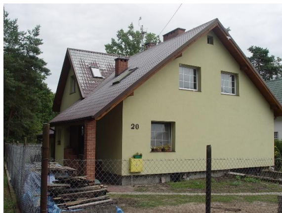
Widok od strony południowo - zachodniej.
