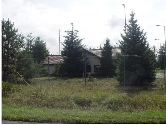
Widok od strony północnej.
