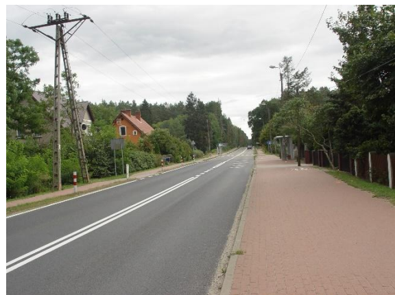
Widok od strony południowej.
