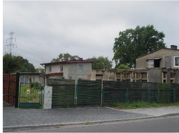
Widok od strony północnej.
