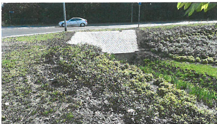
fot. skarpa nad przepustem po pracach
