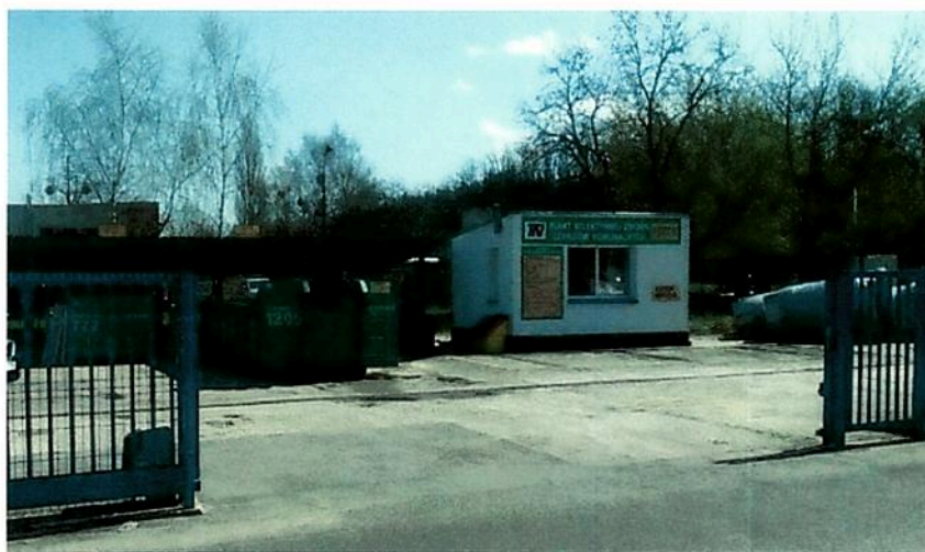
Fot. nr 4 PSZOK – Punkt Selektywnej Zbiórki Odpadów Komunalnych
