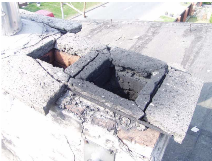
Fot. 6 - Uszkodzona nakrywa betonowa na kominie - stan obecny (V.2018r.)
