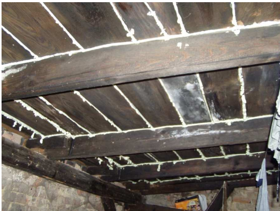
Fot.21 - "Zabezpieczenie" dachu przed przeciekaniem przez mieszkańców budynku poprzez wypełnienie przestrzeni między deskami pianką montażową (V.2018r.)
