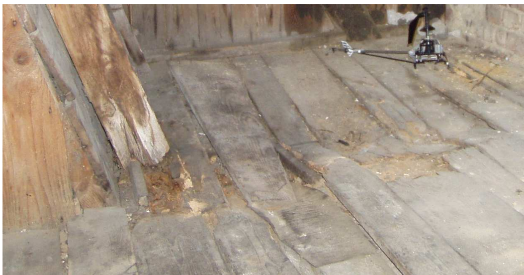
Fot.19 - Przykład zniszczenia podłogi w miejscu przeciekania wód opadowych przez istniejące nieszczelności w dachu (V.2018r.)
