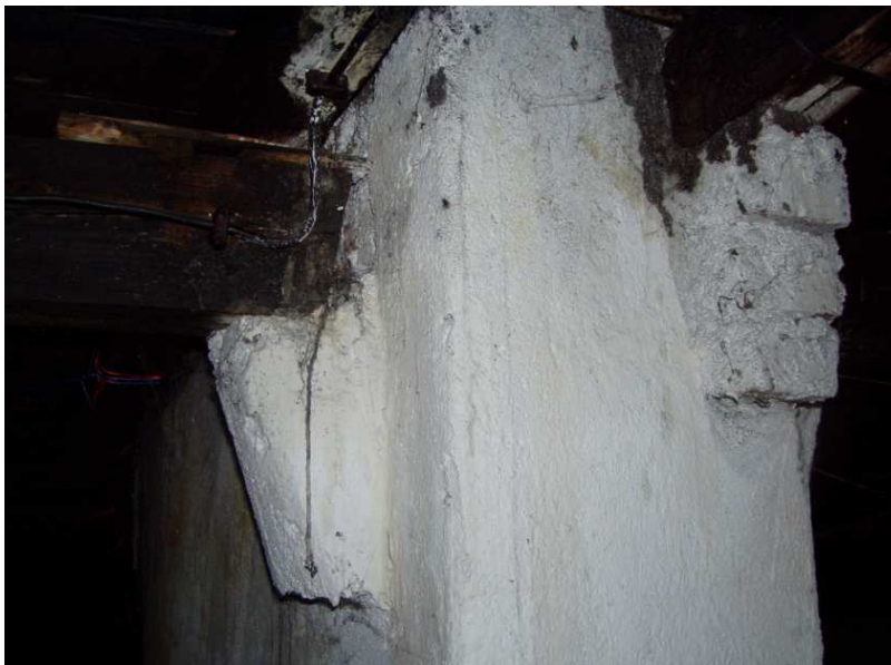
Fot. 9 - Wsporniki wymurowane na trzonie kominowym, podpierające płatwie pośrednie i krokwie dachu (V.2018r.)
