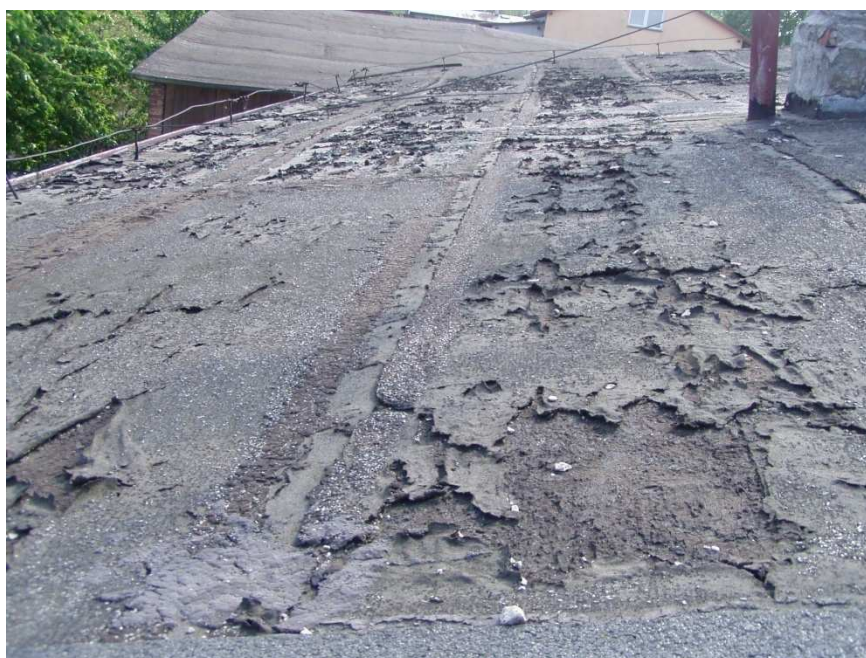
Fot. 4 i 5 - Istniejące pokrycie dachu z papy asfaltowej - stan obecny (V.2018r.)
