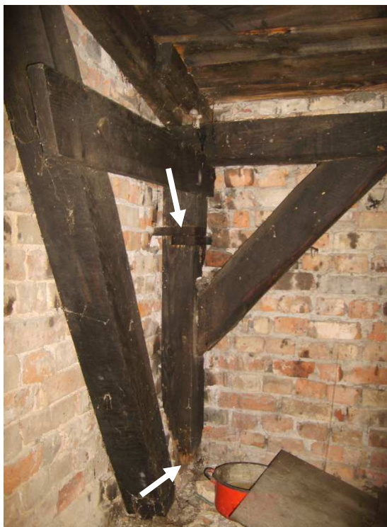
Fot. 10 - Elementy ścianki stolcowej w narożniku budynku od frontu - stan obecny; strzałkami zaznaczono przymocowanie słupka klamrami stalowymi do ścian zewnętrznych poddasza (strzałka górna) oraz zupełny ubytek słupka przy podstawie (strzałka dolna)
