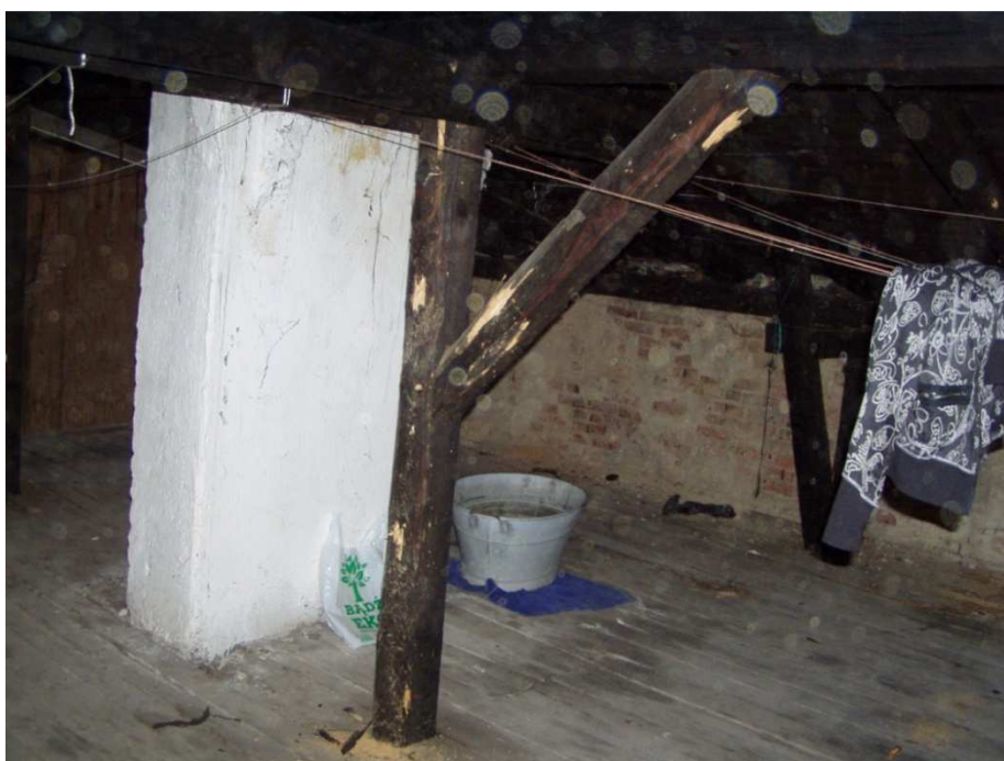
Fot.18 - Jeden ze słupów środkowych dachu; w głębi widoczna balia i szmaty ustawione w celu zbierania wody opadowej w miejscu przeciekania wód opadowych przez istniejące nieszczelności w dachu (V.2018r.)
