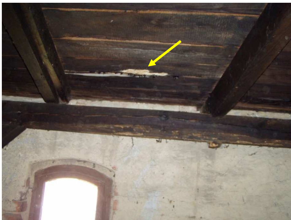
Fot.20 - Aktywne ognisko porażenia grzybem ujawnione na deskowaniu w rejonie ściany zewnętrznej od strony podwórza (V.2018r.)
