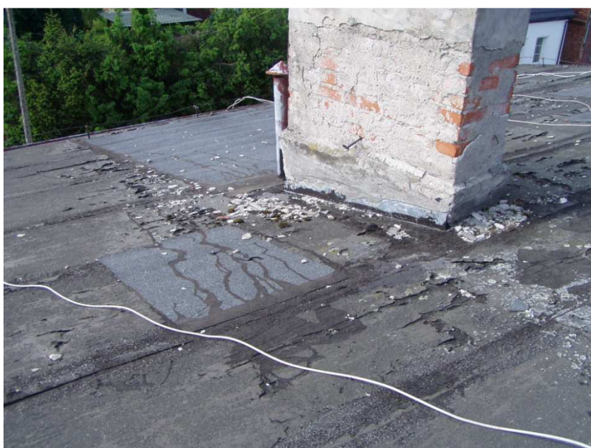
Fot. 2 i 3 - Istniejące pokrycie dachu z papy asfaltowej, kominy - stan obecny (V.2018r.)
