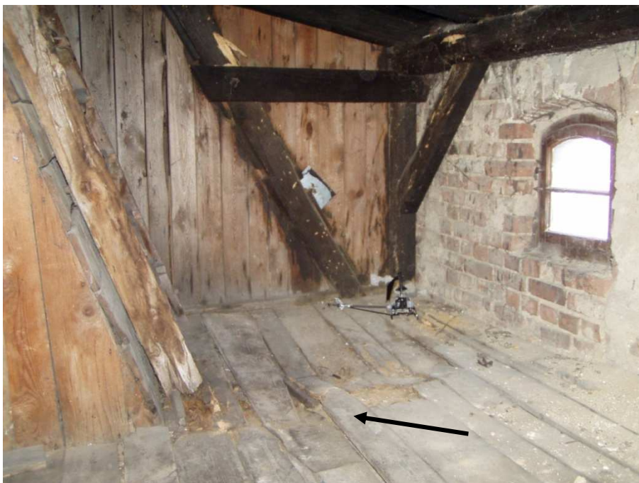
Fot.17 - Elementy ścianki stolcowej w rejonie wyłazu dachowego i całkowite zniszczenie podłogi z desek w miejscu bezpośrednio pod wyłazem (V.2018r.)
