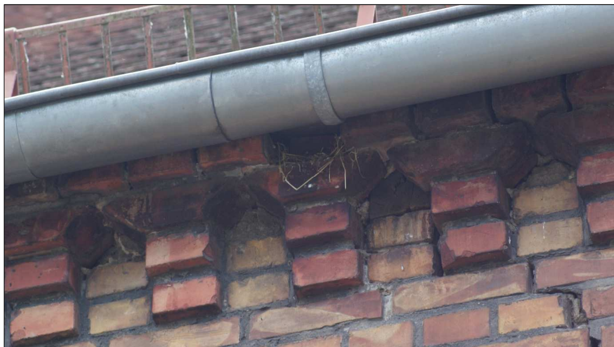
Fot. 7. Gniazdo kopciuszków w otworze na tylnej ścianie budynku (nr 5).
