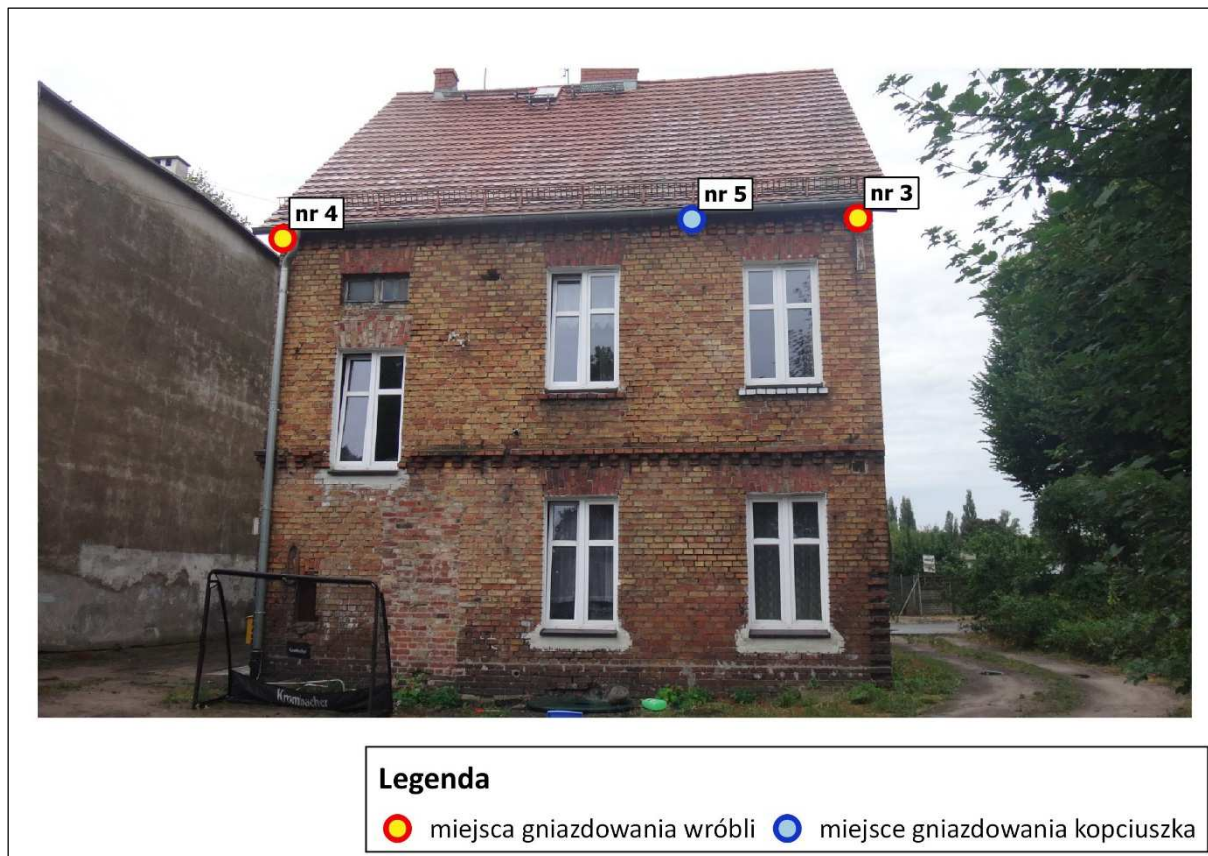
Ryc. 4. Usytuowanie miejsc gniazdowania ptaków na elewacji północno-wschodniej (od strony podwórza).
