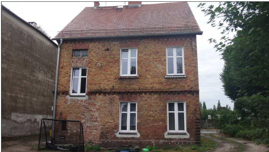
Fot. 2. Tylna elewacja budynku – od strony północno-wschodniej (od podwórza).
