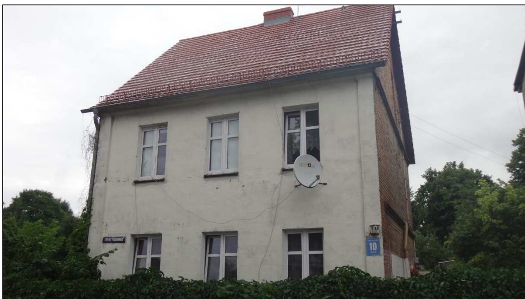
Fot. 1. Frontowa elewacja budynku – od strony południowo-zachodniej (od ul. Starzyńskiego).
