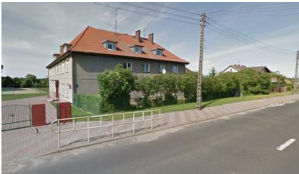
Fotografia budynku na którym zamontowana będzie syrena
