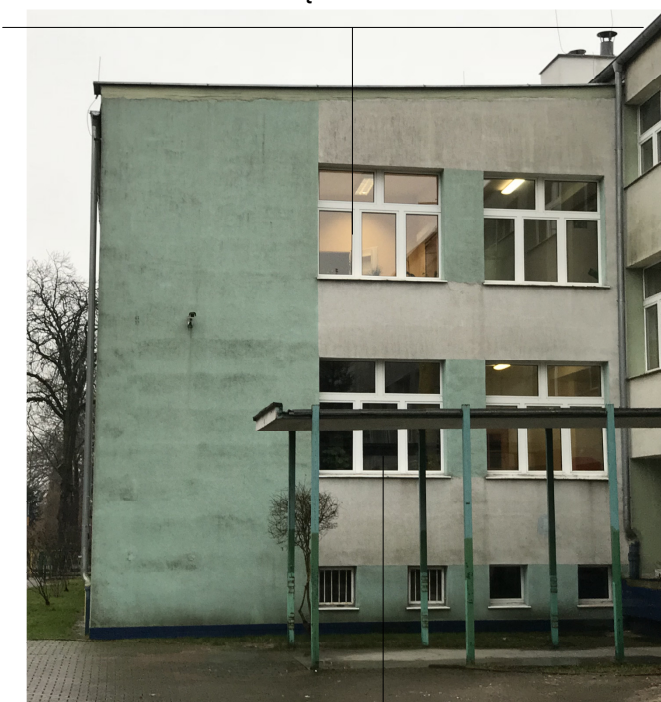
OKNO PRZEZNACZONE DO WYMIANY - POM.1.1 WYMIANA WYNIKAJĄCA Z UWARUMLOWAŃ P.POŻ
