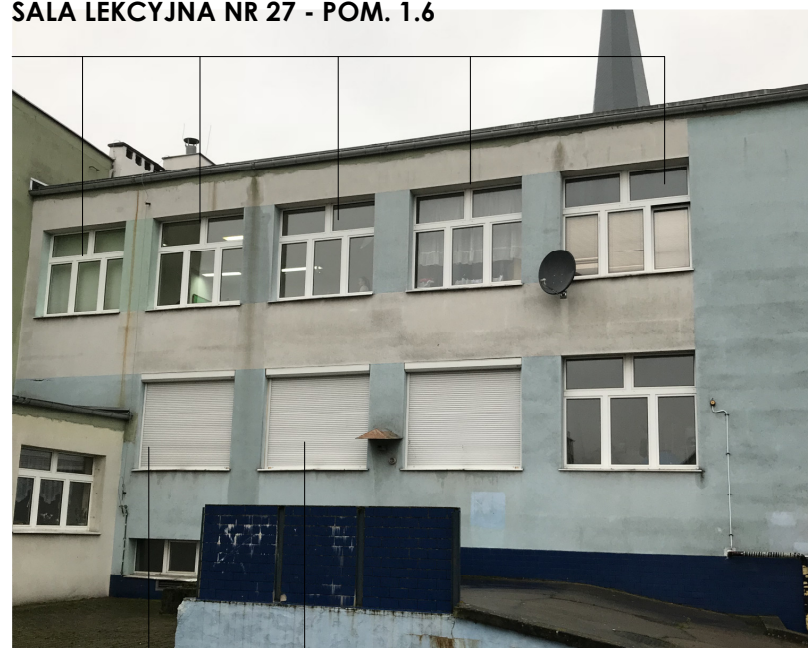
OKNA PRZEZNACZONE DO WYMIANY: SALA LEKCYJNA NR 27 - POM. 1.6
