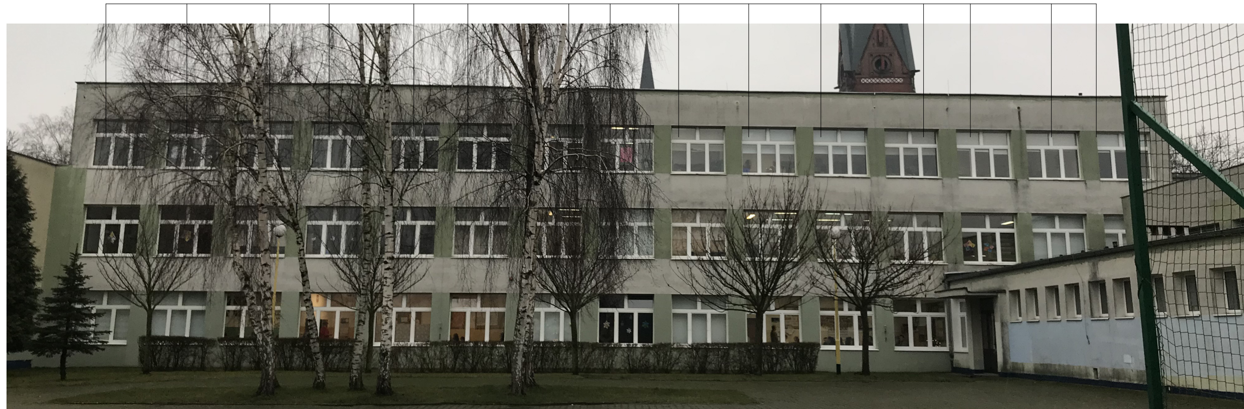
OKNO PRZEZNACZONE DO WYMIANY - POM.1.1 WYMIANA WYNIKAJĄCA Z UWARUMLOWAŃ P.POŻ
