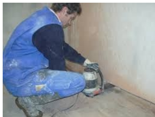
Wykonanie podcięcia piłą ręczną
