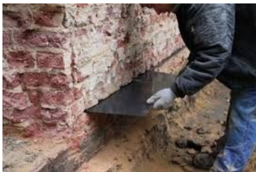
Wykonanie izolacji z płyty poliestrowej 9.2.1. Materiały i sprzęt dla wykonania podcinki
