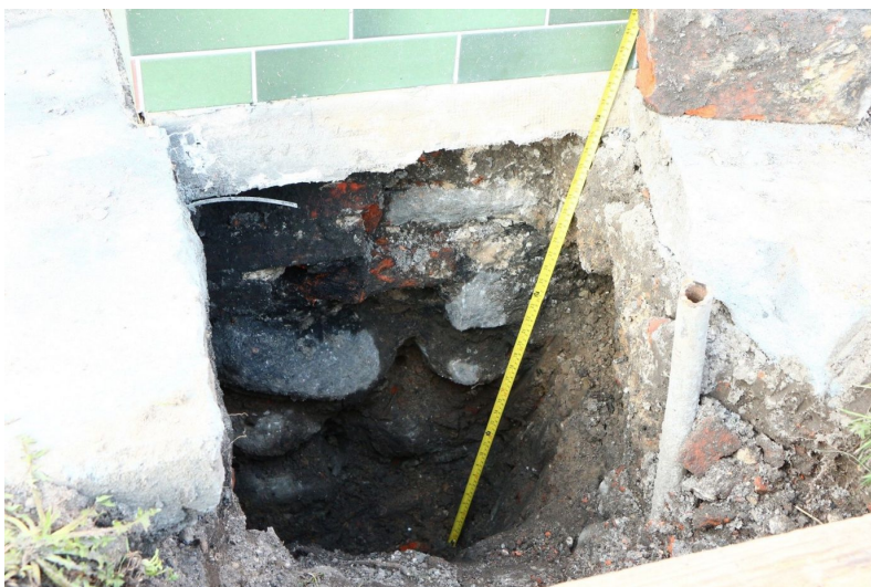
Część budynku niepodpiwniczonego, brak izolacji pionowej i poziomej - na podstawie odkrywki.
