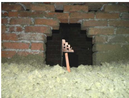
Nadmuch materiału izolacyjnego.
