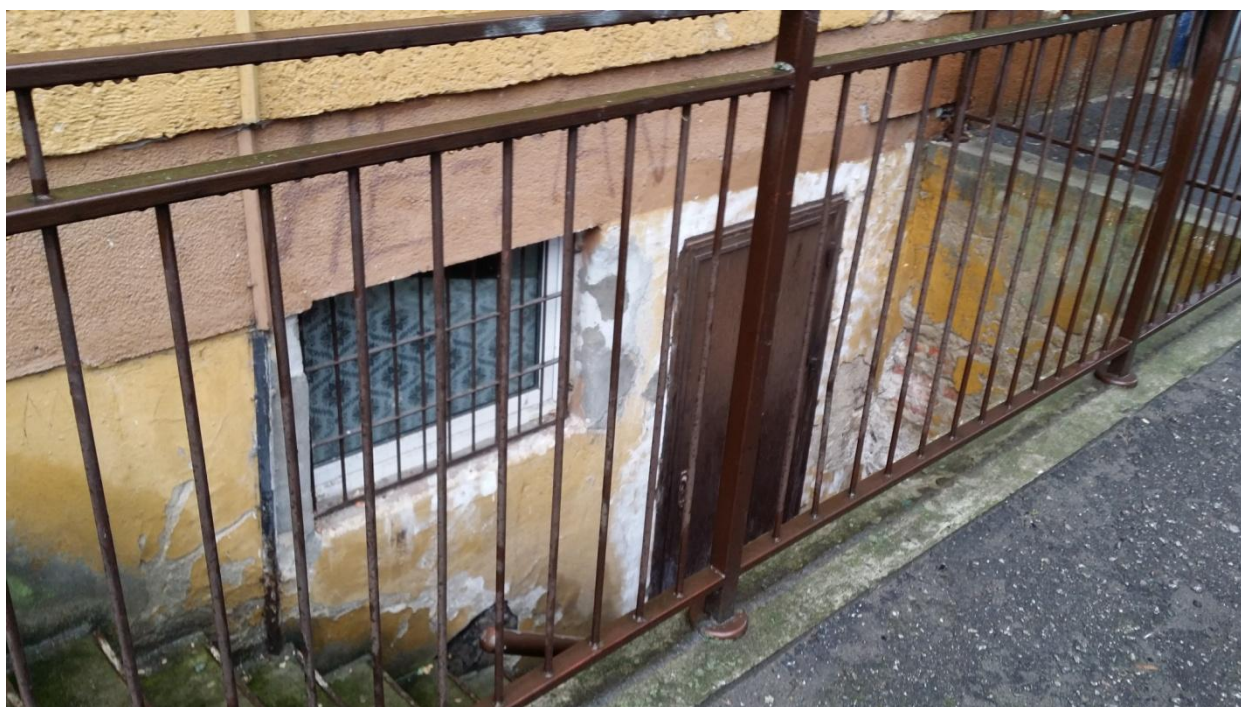
Elewacja tylna - budynek przy ul. Bankowej nr 18 zejście do części piwnicznej , widoczne uszkodzenia tynku zewnętrznego
