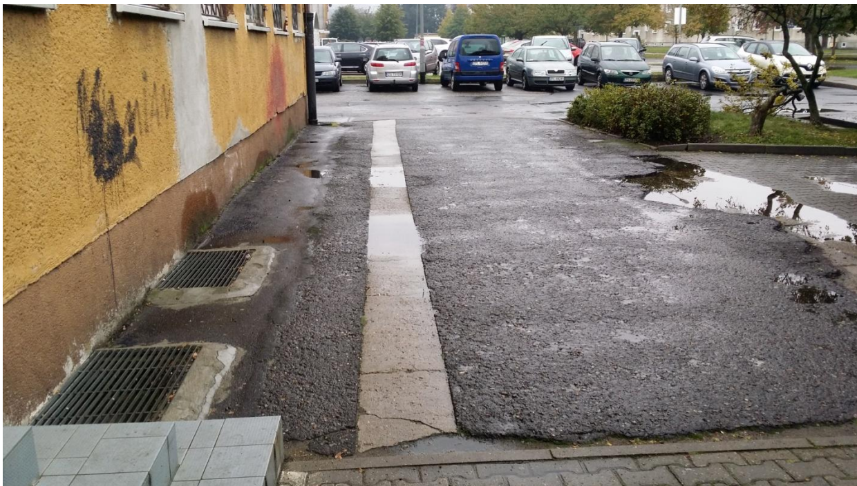
Elewacja frontowa budynek przy ul. Bankowej nr 18 widoczne studzienki piwniczne , warstwa cokołowa i powyżej warstwa tynku elewacyjnego typu terrabona malowana
