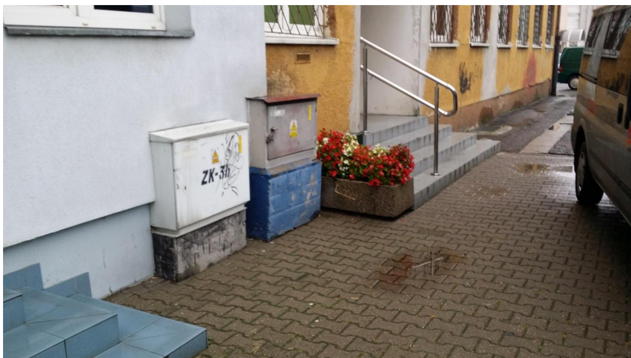
Wejście do budynku przy ul. Bankowej nr 18 , brak podjazdu dla niepełnosprawnych co stanowi barierę architektoniczną.
