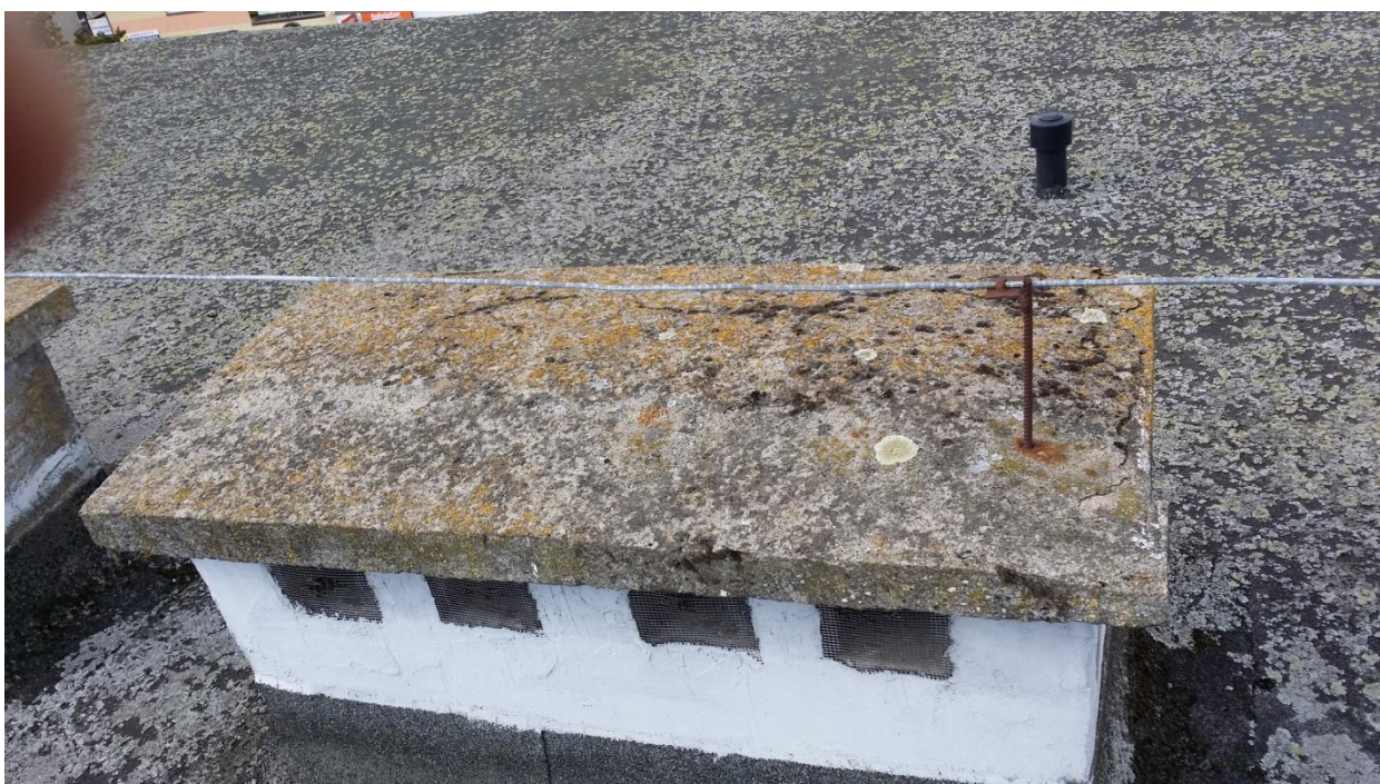
Kominy wentylacyjne nieocieplone, czapki kominowe widoczne pęknięcia i zarysowania.
