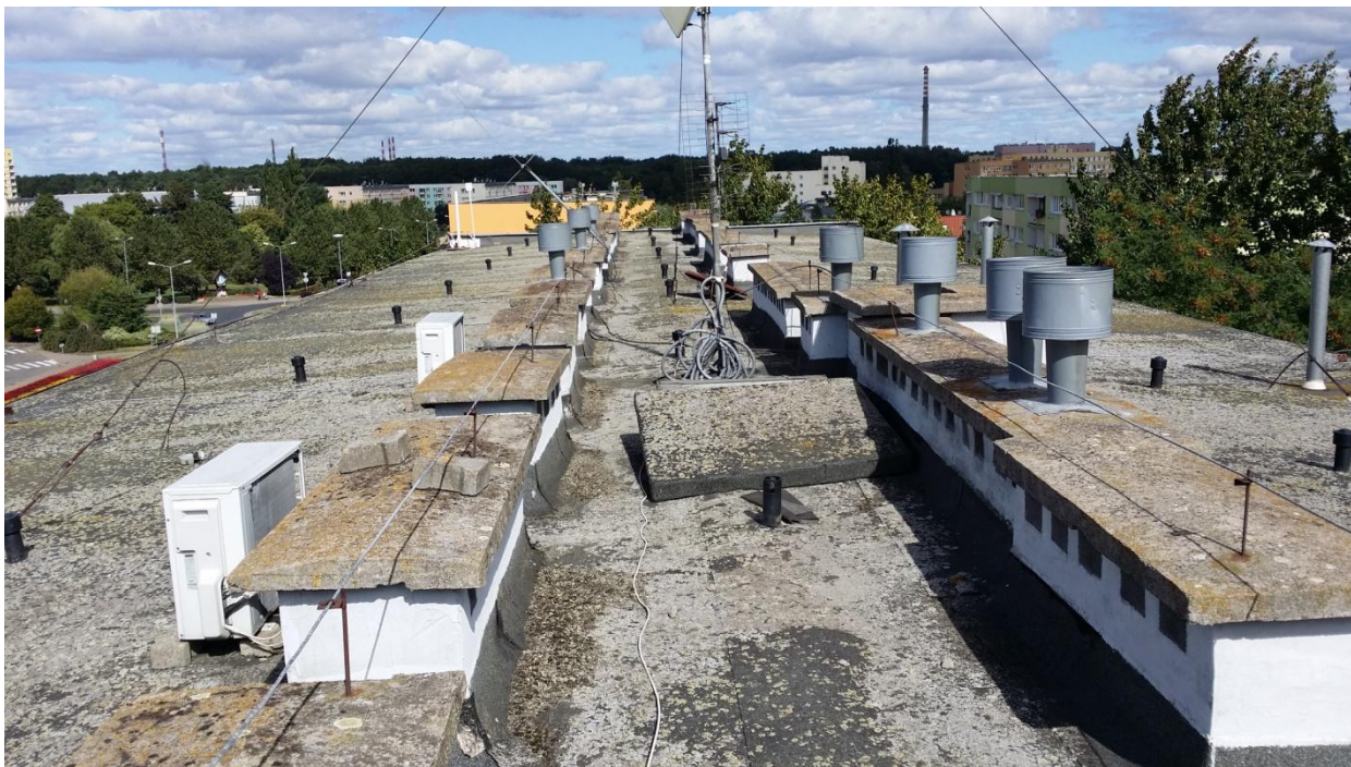
Dach budynku przy ul. Bankowej nr 18 , pokrycie papą , widoczne ślady zużycia , na dachu widoczna instalacja odgromowa oraz wywiewki wentylacyjne. Warstwa papy pokryta nalotem glonów.
