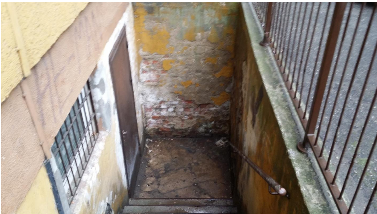
Zejsście do piwnicy od strony elewacji tylnej , widoczne uszkodzenia tynku zewnętrznego ścian zejścia pochodzące od zawilgocenia
