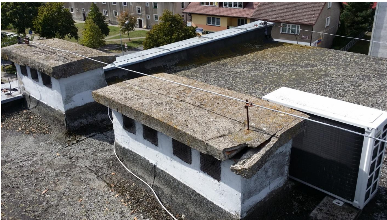
Czapki kominowe - widoczne pęknięcia i uszkodzenia.
