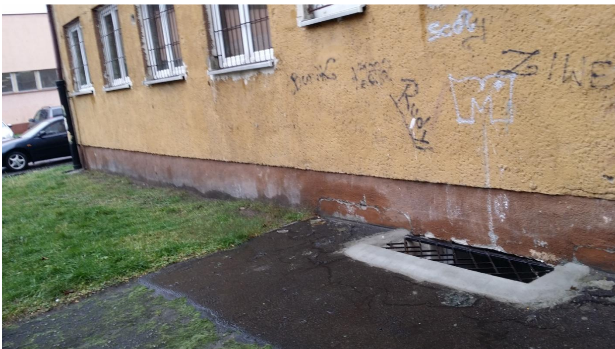
Elewacja tylna - budynek przy ulicy Bankowej nr 18 - na zdjęciu widoczna studzienka do świetlniowa piwniczna
