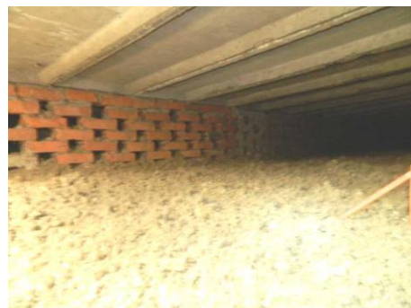
Nadmuch materiału izolacyjnego
