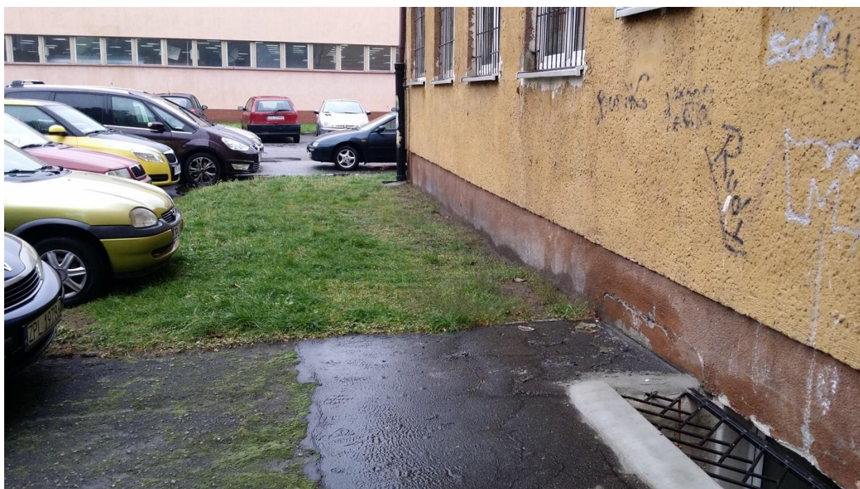
Elewacja tylna budynku przy ul.Bankowej nr 18 , wqęstwa cokołowa - tynk cementowo - wapienny malowany , wyżej elewacja nieocieplana wykonania jako tynk zewnętrzny typu terabona
