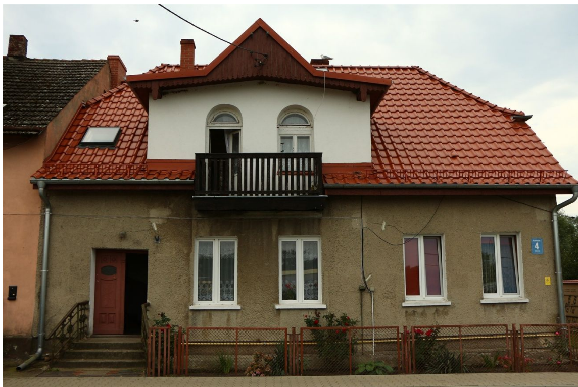
Elewacja pn - wsch. nieocieplona - ściana frontowa budynku ul. Portowa 4
