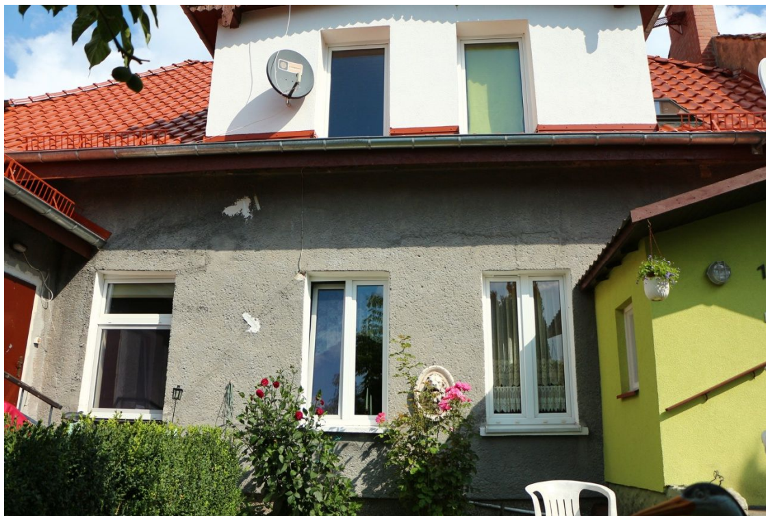
Elewacja pn - wsch. nieocieplona - ściana frontowa budynku ul. Portowa 4
