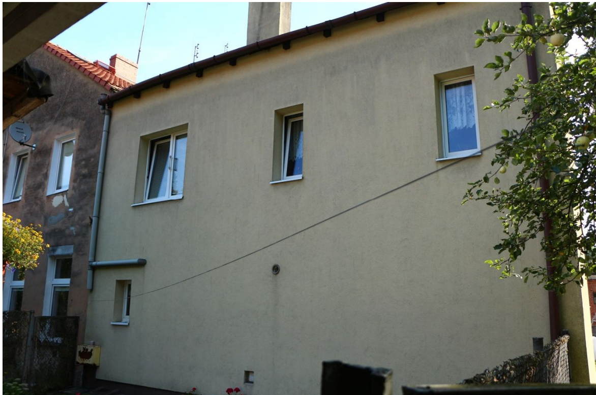
Część docieplona - otwory do zamurowania
