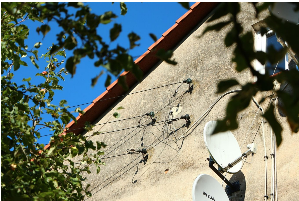
Przylącze energetyczne napowietrzne - do demontażu , anteny satelitarne do demontażu.
