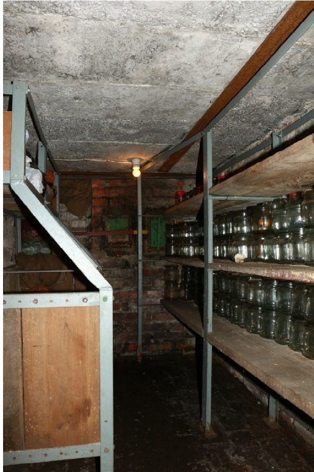
Strop nad piwnicą - strop WPS
