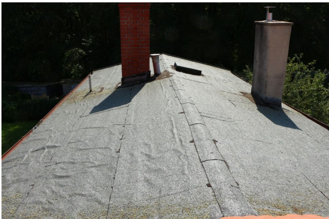
Dach część dobudowana - dach pokryty papą stan po remoncie
