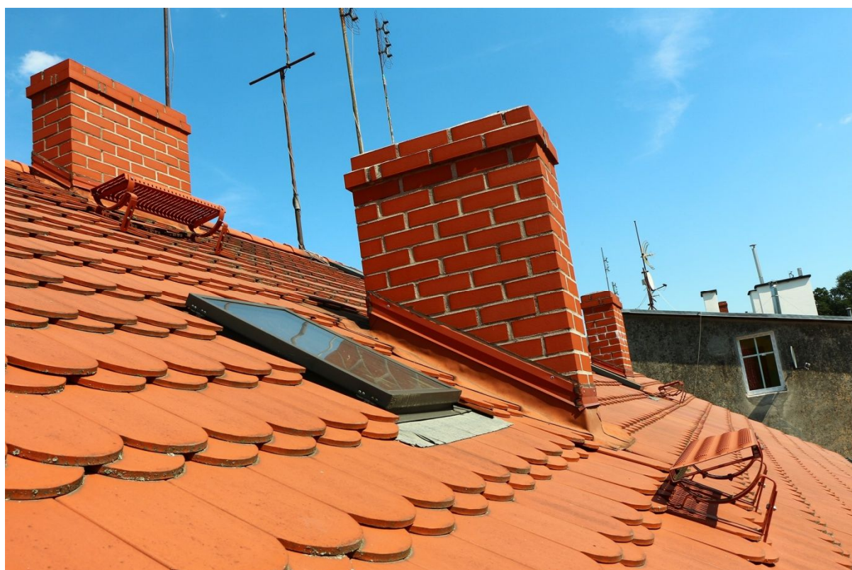
Dach budynek główny po remoncie - kominy z klinkieru po remoncie Dach kryty dachówką karpiówką podwójnie - stan po remoncie
