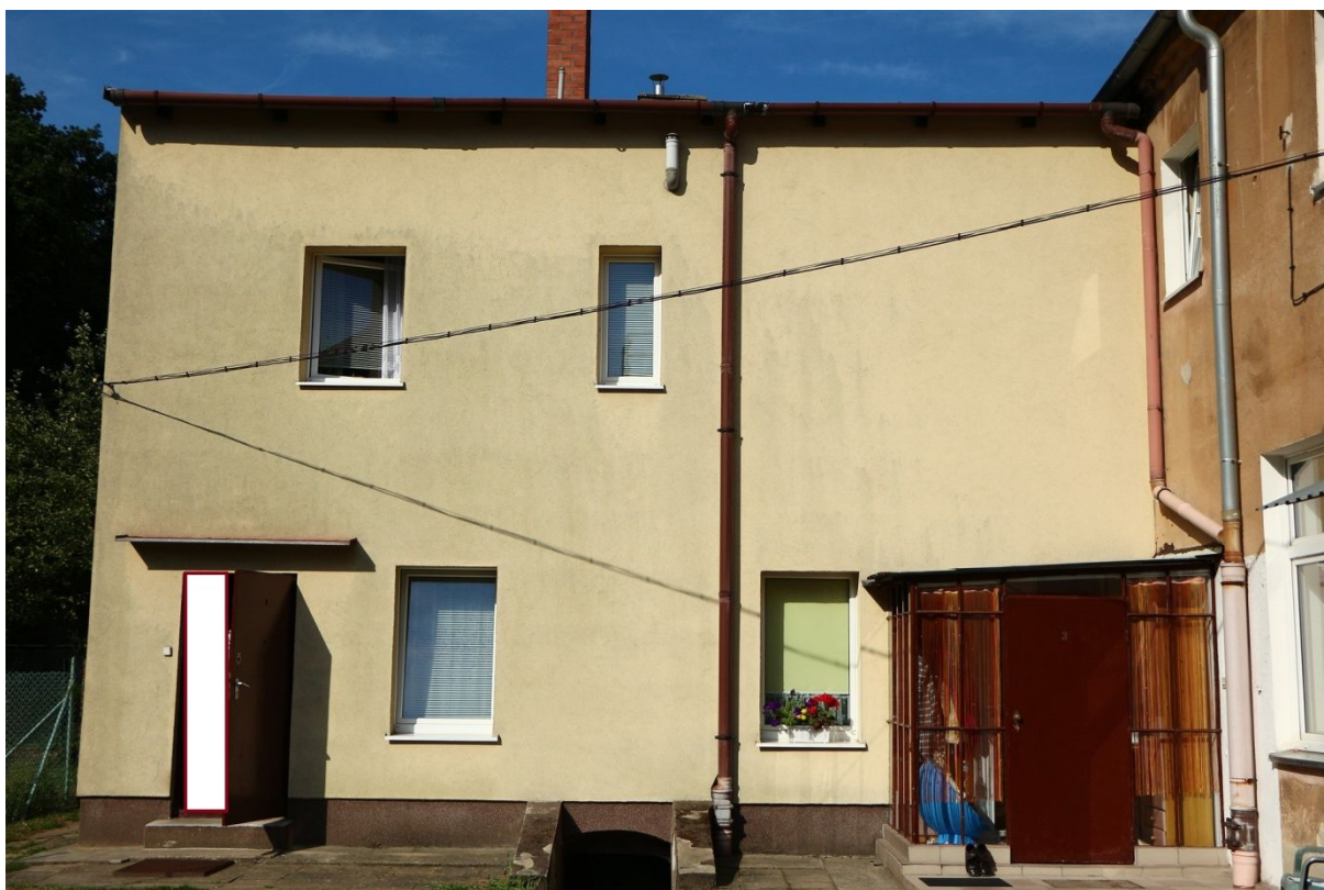
Elewacja wsch. - część dobudowana ocieplona
