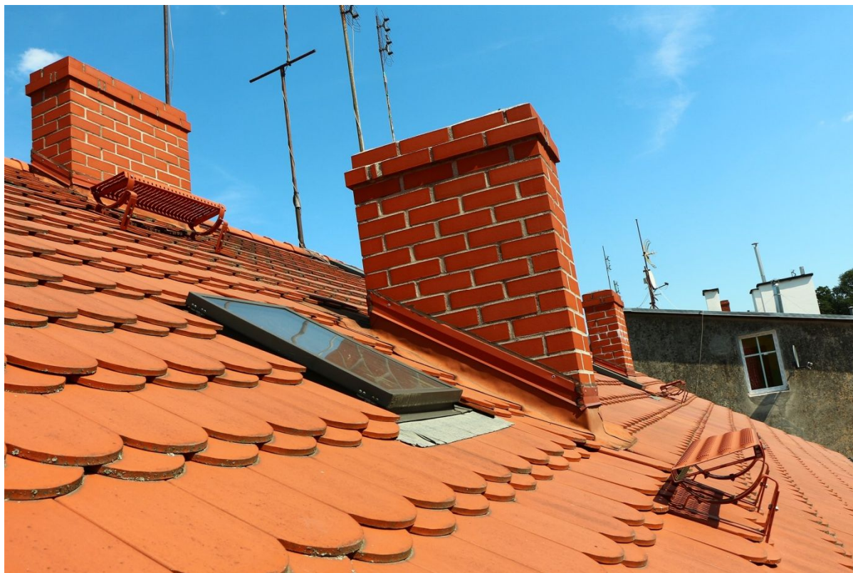
Dach budynek główny po remoncie
