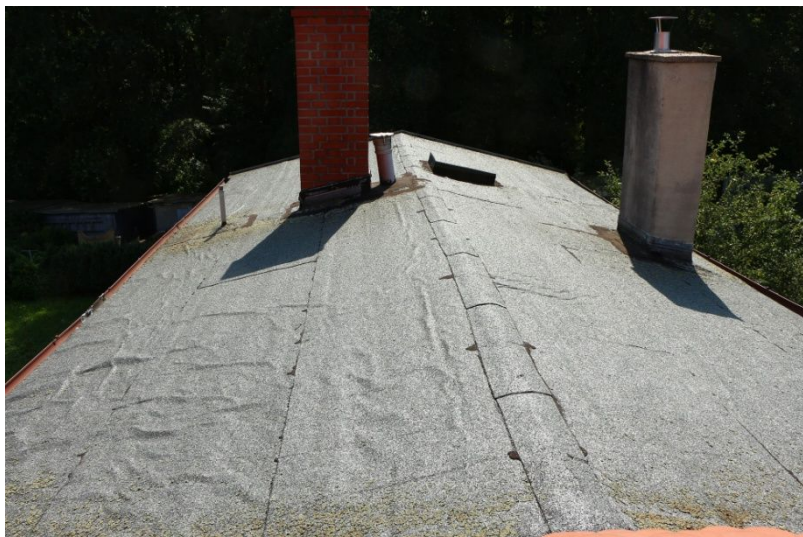
Dach część dobudowana - po remoncie
