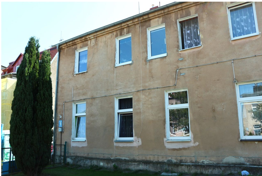
Elewacja pn - ściana frontowa budynku ul. Palmowa nr 5
