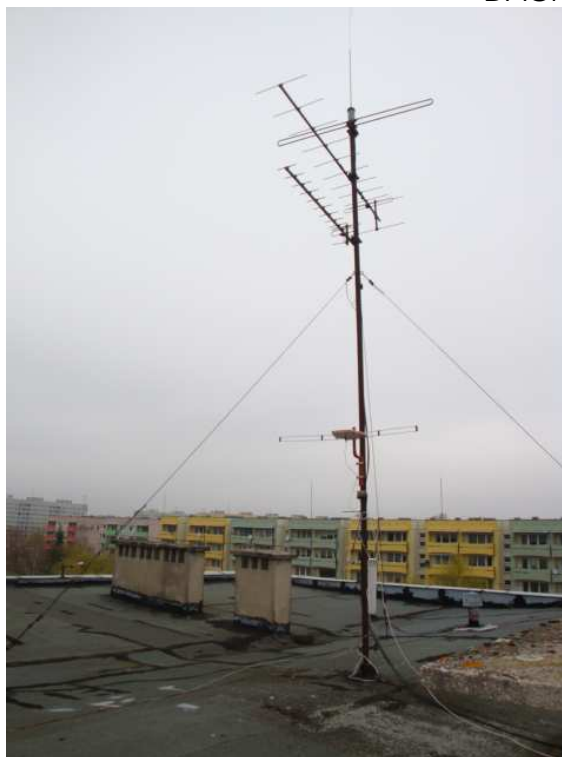
BUDYNEK C DACH
