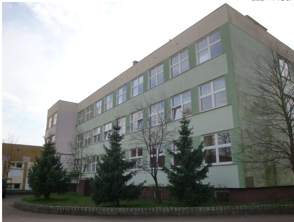
BUDYNEK C ELEWACJA
