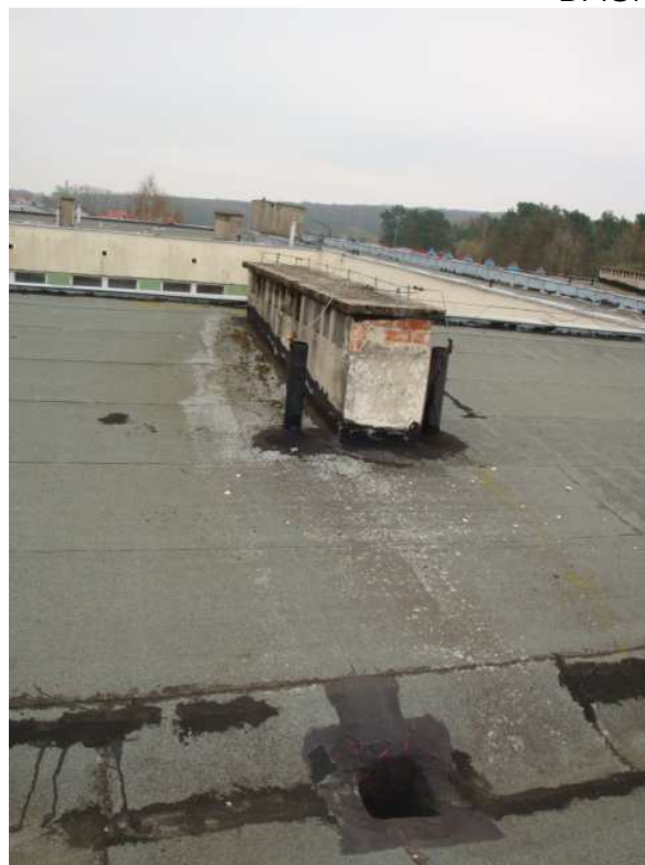
BUDYNEK B DACH
