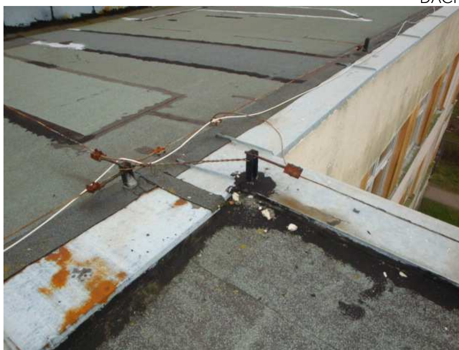
BUDYNEK B DACH
