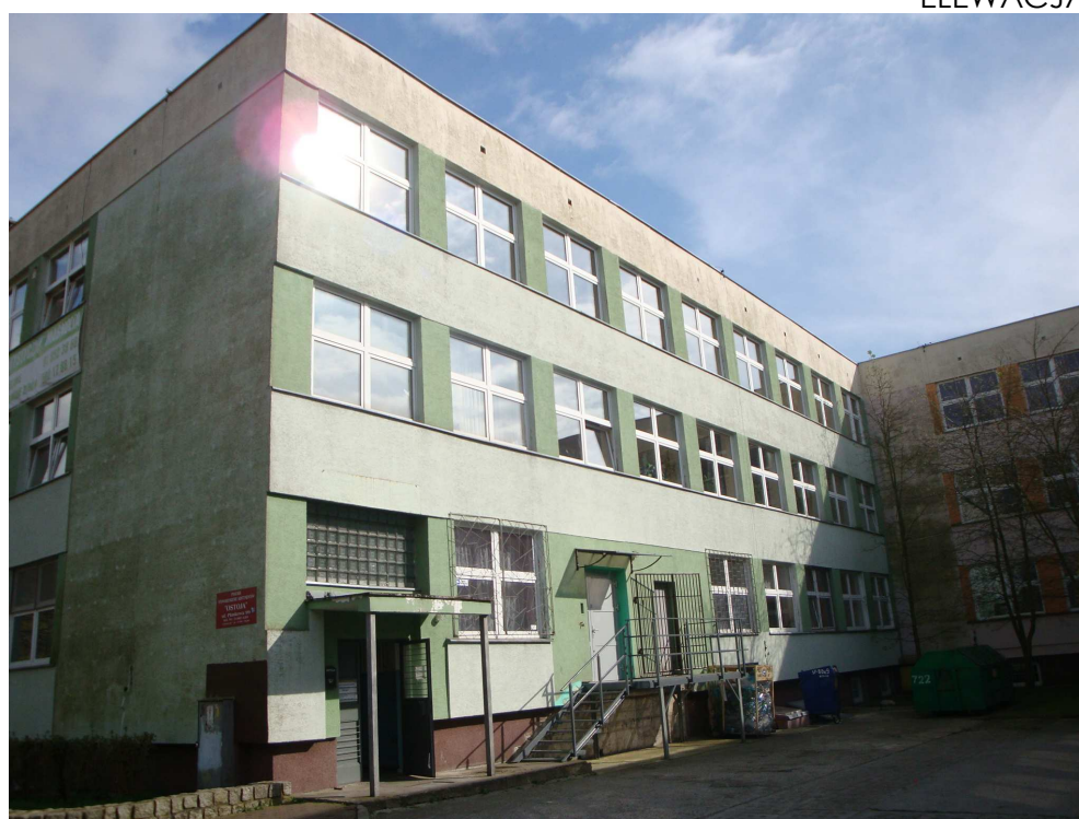
BUDYNEK C ELEWACJA
