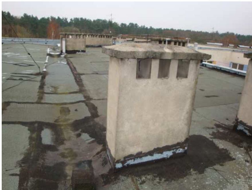
BUDYNEK C DACH
