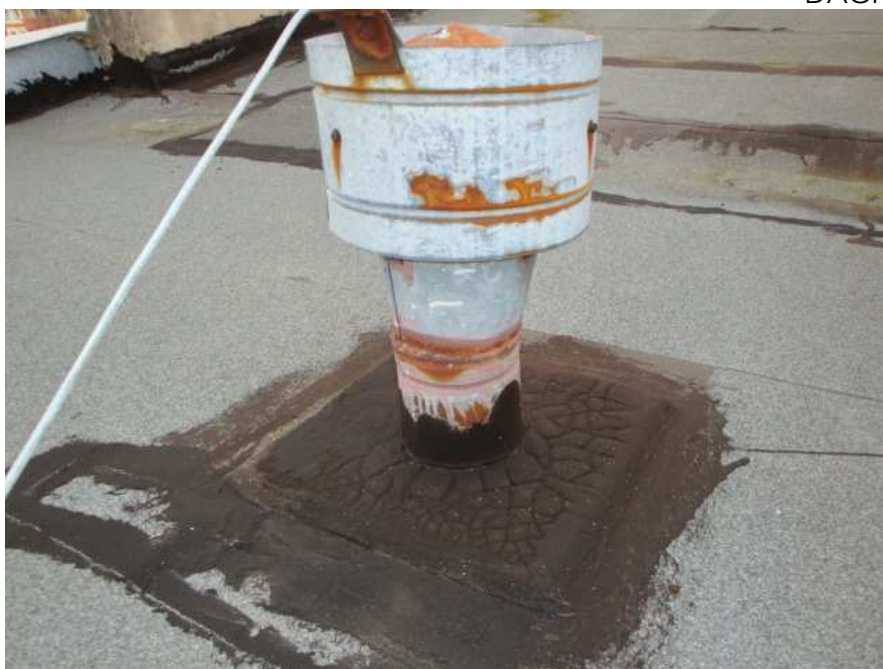
BUDYNEK C DACH
