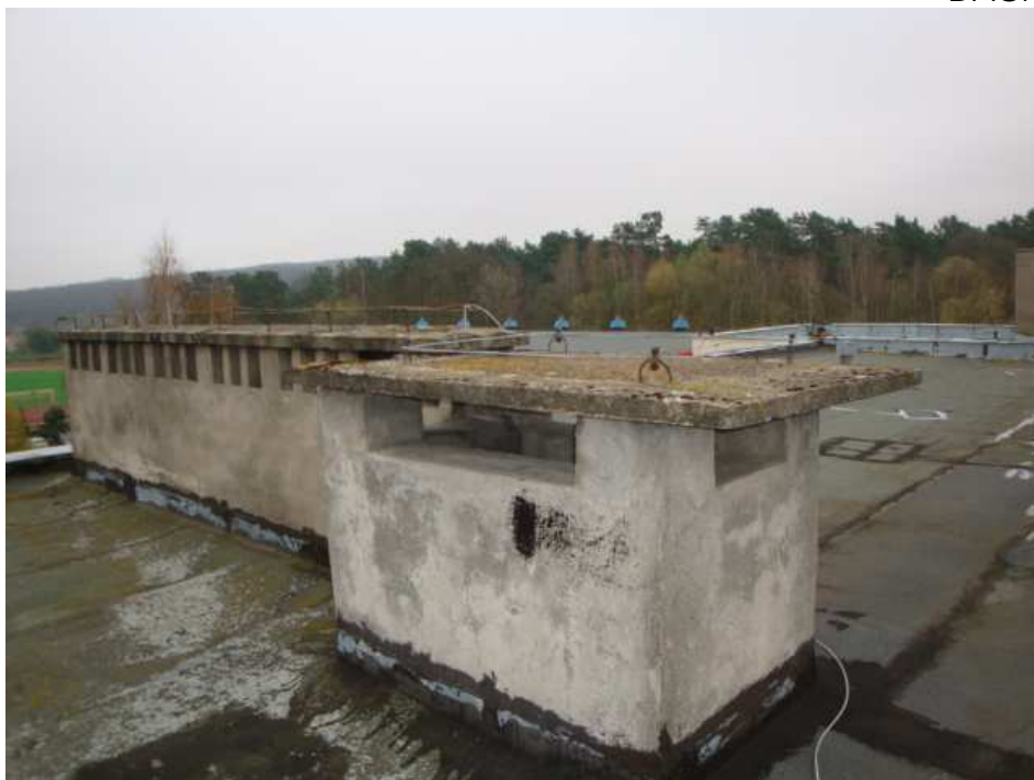
BUDYNEK C DACH
