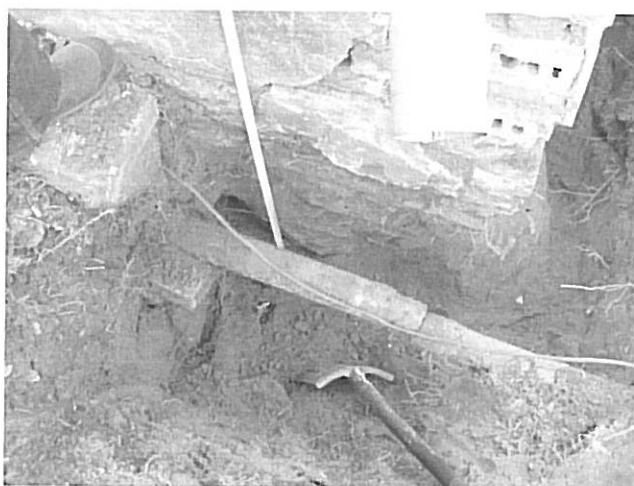
fot.6 - Odkrywka fundamentowa w płn-wsch. narożniku budynku - - widok od strony podwórza
