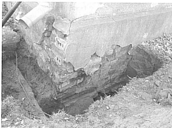
fot.4 - Odkrywka fundamentowa w płn-wsch. narożniku budynku - - w widoku od strony płn. ściany szczytowej
