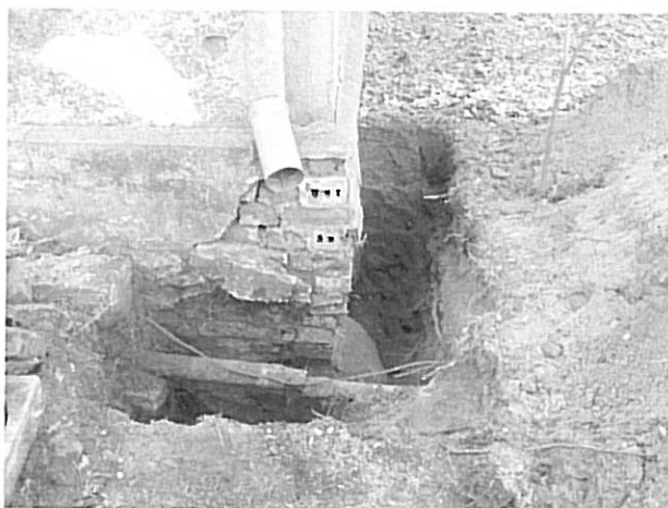
fot.5 - Odkrywka fundamentowa w płn-wsch. narożniku budynku - - widok od strony podwórza
