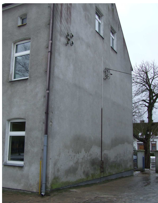
WIDOK NA ELEWACJĘ SZCZYTOWĄ, OD STRONY WJAZDU NA DZIAŁKĘ
