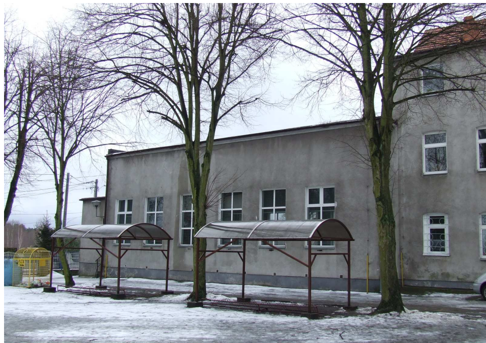
WIDOK ELEWACJI SALI GIMNASTYCZNEJ OD STRONY BOISKA
