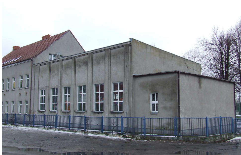
WIDOK ELEWACJI SALI GIMNASTYCZNEJ OD STRONY UL. KASZTANOWEJ
