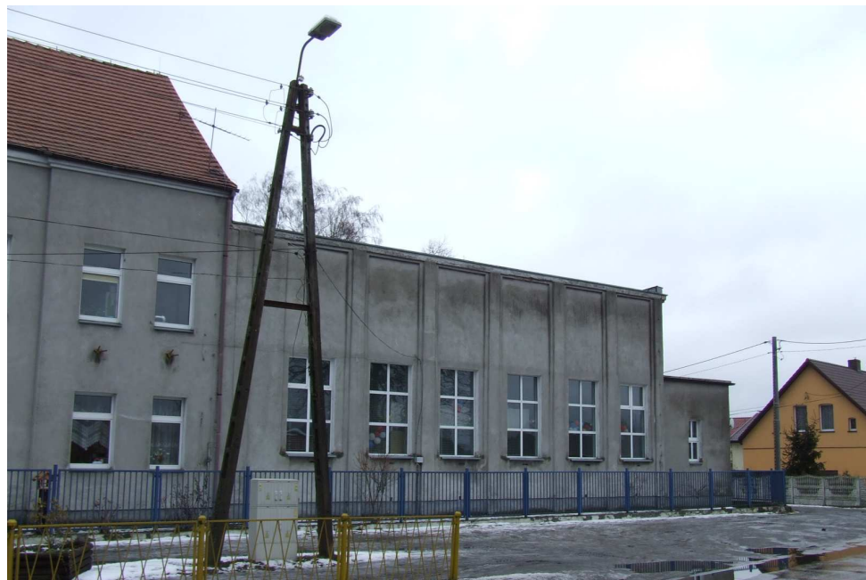
WIDOK ELEWACJI SALI GIMNASTYCZNEJ OD STRONY UL. KASZTANOWEJ
